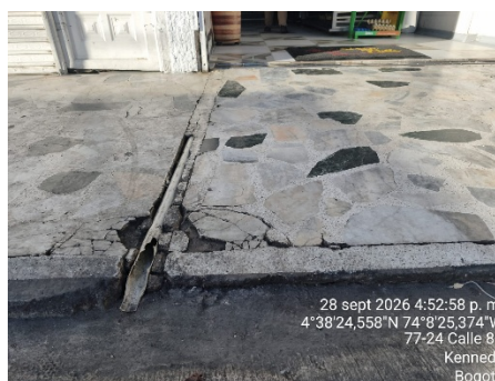
Fotografía No. 2 Tubería con salida hacia la vía pública – establecimiento Gran Pollo
