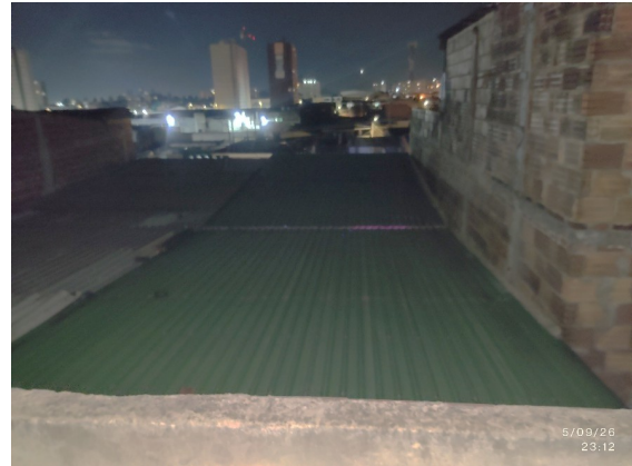
Fotografía No. 4. Registro techo en Teja
