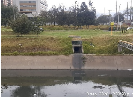
Fotografía 13. Estructura asociada a la red local pluvial CSF-RFU-0950 (04°39'22.320"N; 74°07'56.924"W).
