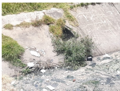
Fotografía 8. Estructura asociada a la red local pluvial CSF-RFU-0780 (04°39'40.243"N; 74°07'33.097"W).
