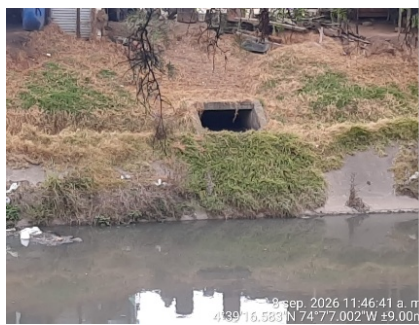
Fotografía 5. Estructura asociada a la red local pluvial CSF-RFU-0590 (04°39'16.583"N; 74°07'07.002"W).
