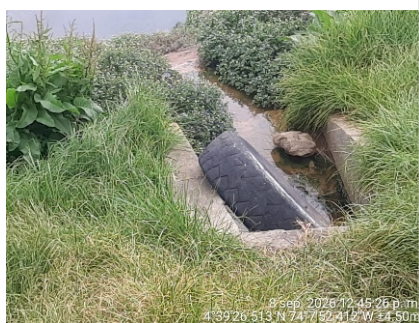
Fotografía 11. Estructura asociada a la red local pluvial CSF-RFU-0860 (04°39'26.513"N; 74°07'52.412"W).
