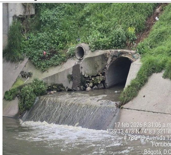
Fotografías 3 y 4. El punto corresponde a la inspección realizada el 17/02/2026 a la estructura de descarga Red Troncal Sanitaria, Interceptor con código RFU-T4-0130.
