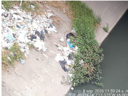
Fotografía 6. Estructura asociada a la red local pluvial CSF-RFU-0641 (04°39'22.493"N; 74°07'13.375"W).
