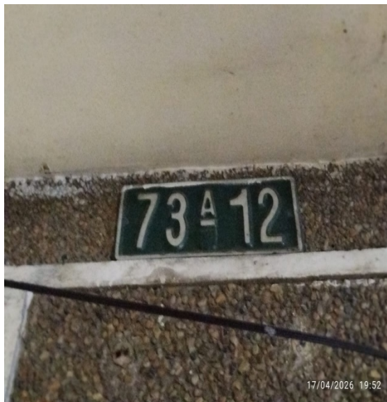
Fotografía No. 2. Vista nomenclatura expuesta en fachada.
