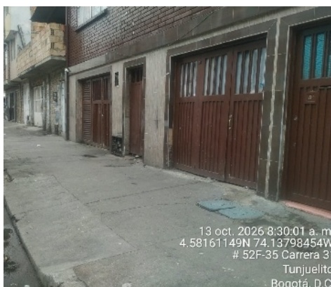
Fotografía 3. Fachada del predio Carrera 31 No. 51 F - 22 Fuente: Tomada en visita el 13/10/2026
