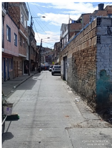
Fotografía No. 3: Final de la cuadra de la calle 127D con carrera 91A.
