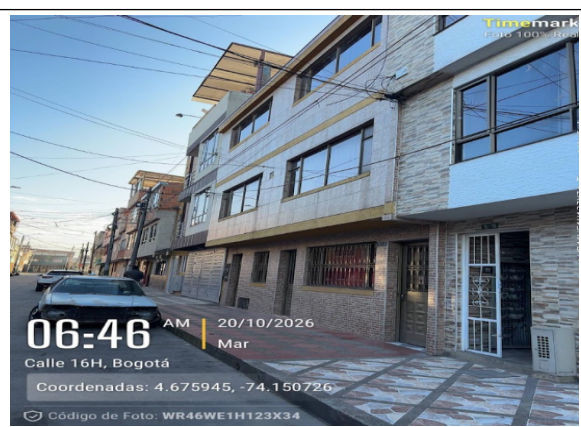
Fotografía 2. Vista general de la zona objeto de estudio.
