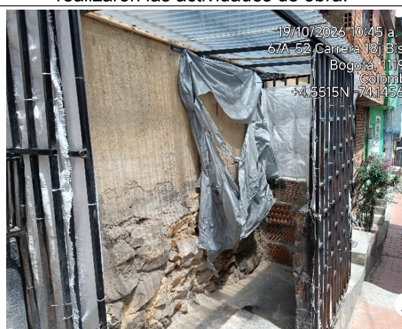
Imagen 4. Reja instalada en frente de la vivienda.
