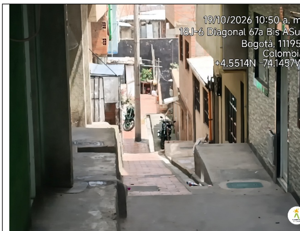
Imagen 1. Vista panorámica de la carrera 18J BIS.
