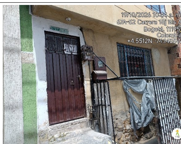
Imagen 2. Vivienda donde se presume se realizaron las actividades de obra.
