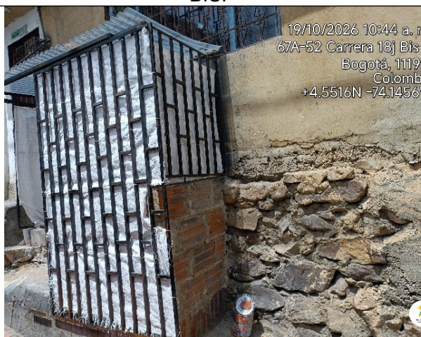
Imagen 3. Ausencia de residuos de construcción en el andén.
