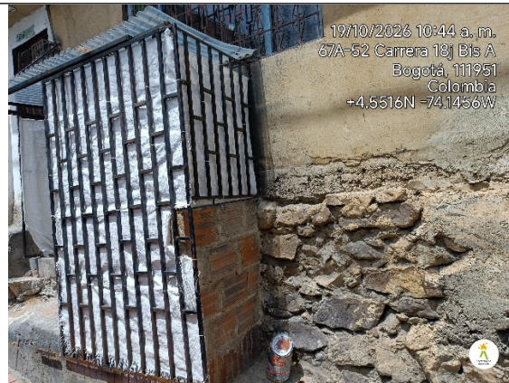
Imagen 4. Ausencia de acopios de residuos adyacente a la vivienda.
