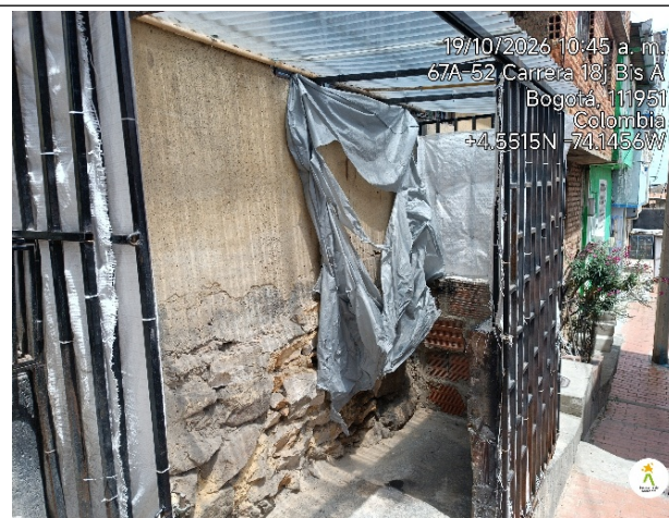
Imagen 4. Reja instalada en frente de la vivienda.
