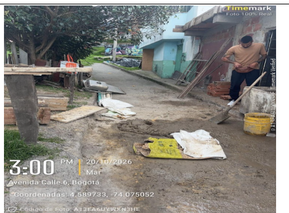
Fotografía 2. Labores de construcción
