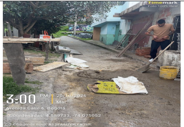
Fotografía 2. Labores de construcción
